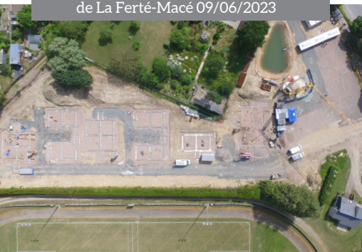
Vue aérienne du chantier de la caserne de La Ferté-Macé 09/06/2023
