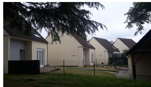
Réhabilitation logements - Courtoimer
