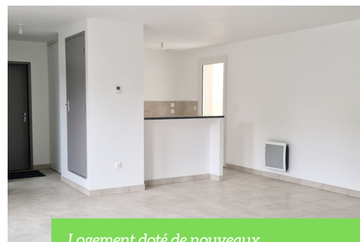
Logement doté de nouveaux convecteurs électriques
